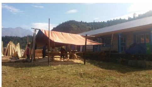
Les menuiseries sont fabriquées sur place.
