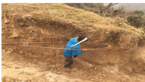
Les barres de fer (de 6 m de long) pour les chainages parasismiques sont transportées à dos d'homme
